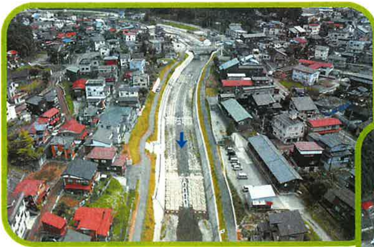
川幅が広がり、コンクリート護岸が整備された田川
