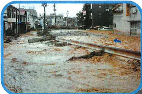
流木・土砂により河道閉塞した晒川
