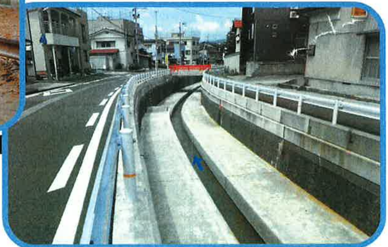
川底がさがり、洪水が流下する面積が拡大した晒川
